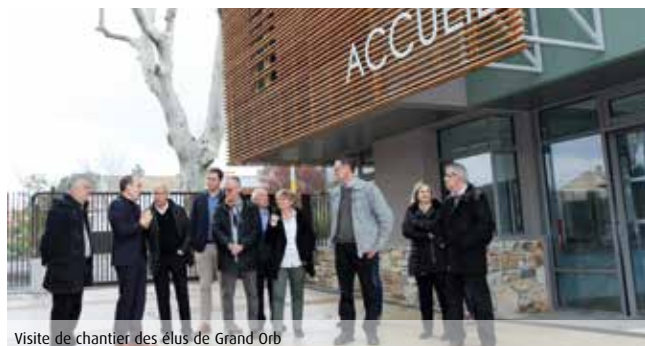
Visite de chantier des élus de Grand Orb
