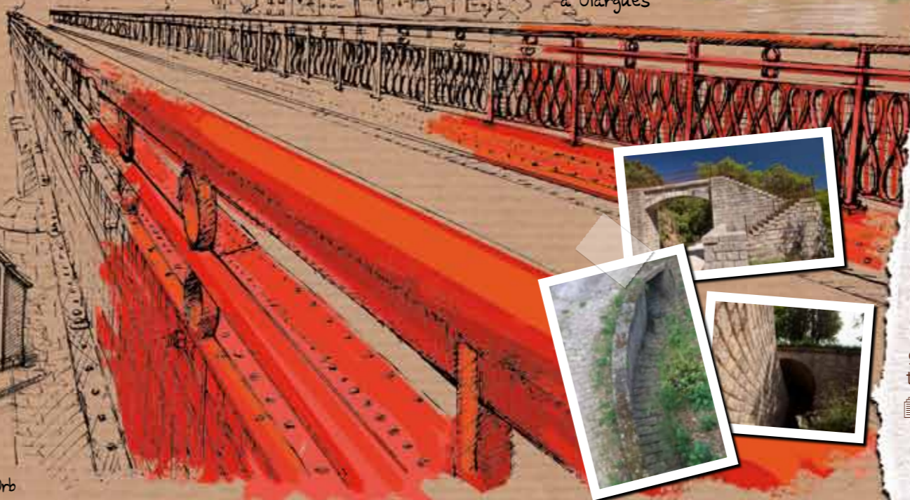
Pont de type Eiffel à Olargues
