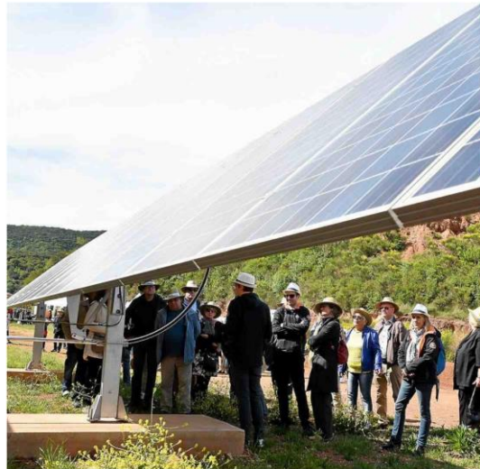
■ Au total, ce sont 25 hectares qui sont recouverts de panneaux photovoltaïques. PIERRE SALIBA
